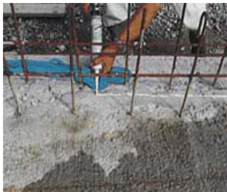
2) Клеящий состав для резинового профиля наносится на чистую и ровную поверхность...
