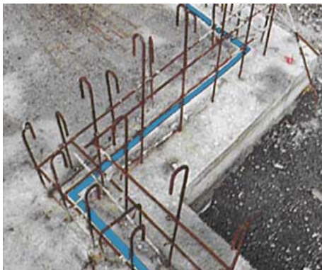
4) Рекомендуемая температура нанесения клея +10°C - +40°C и относительная влажность воздуха не более 80%. После приклеивания выдержать в течение 20 минут.
