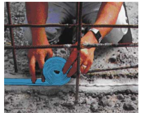
3) ...затем резиновый профиль вдавливается в клеящий состав.
